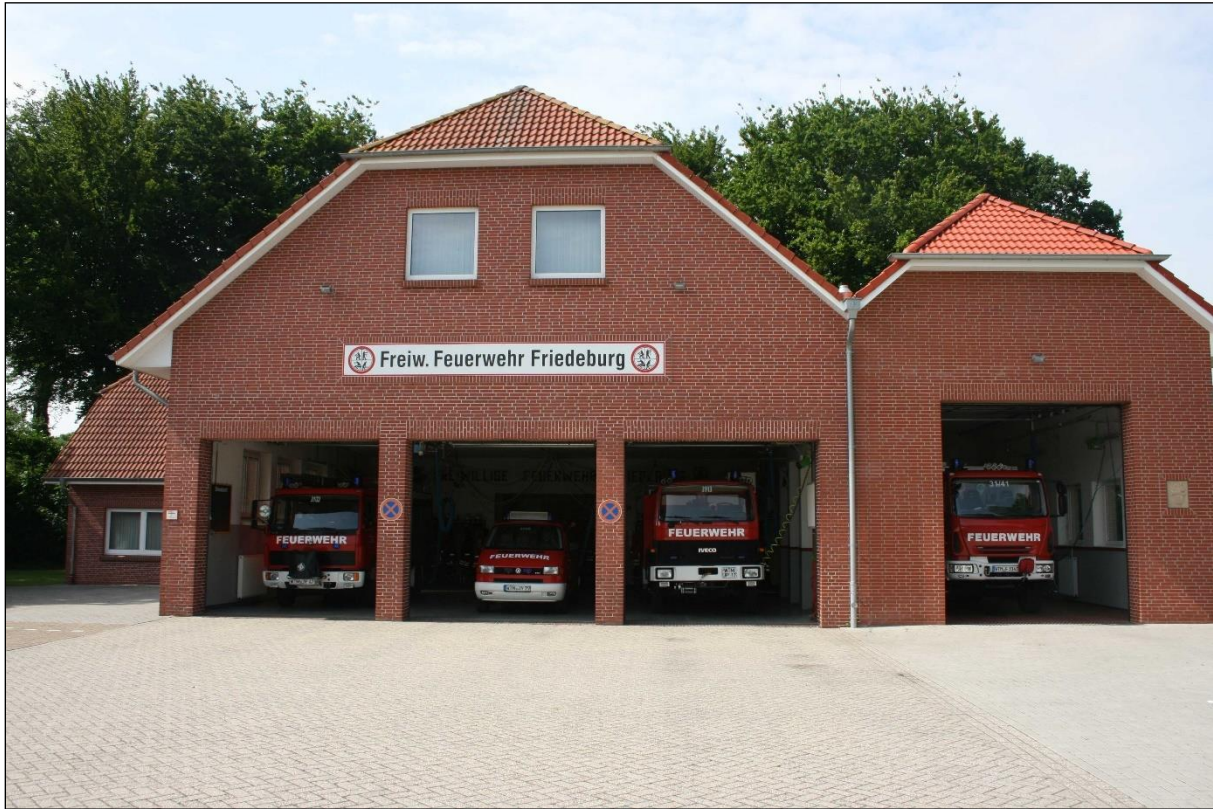
Abbildung 5.3 Foto Feuerwehrhaus Ortsfeuerwehr Friedeburg
