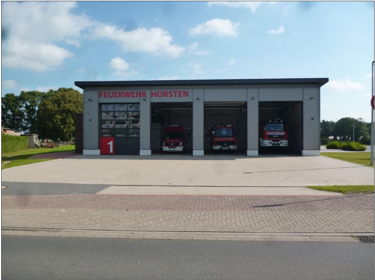
Abbildung 5.4 Foto Feuerwehrhaus Ortsfeuerwehr Horsten
