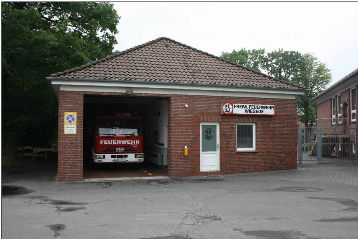
Abbildung 5.7 Foto Feuerwehrhaus Ortsfeuerwehr Wiesede
