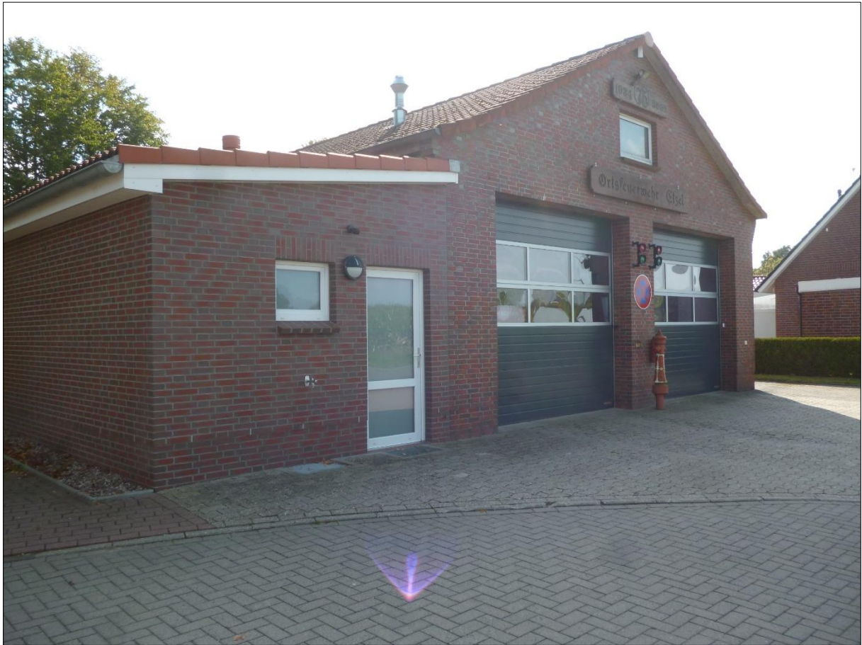
Abbildung 5.2 Foto Feuerwehrhaus Ortsfeuerwehr Etzel
