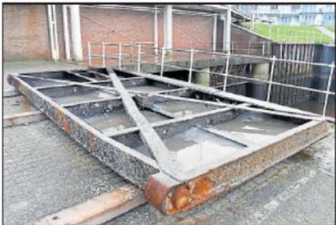
Das am 9. Dezember ausgerissene Schlagtor des Sielwerkes Benersiel soll schnell ersetzt werden. **BILD: KLAUS HÄNDEL**
